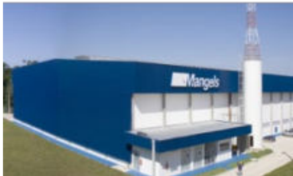
Centro de Serviços de Aços Manaus/AM
