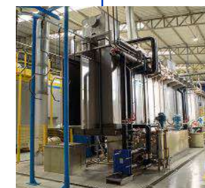
Ampliação da Unidade de Rodas (Nova Linha de Pintura Acrílica)
